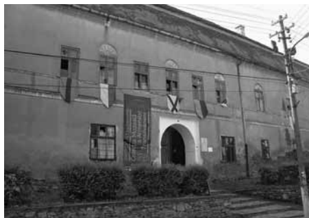
Apafi kastély főbejárata
